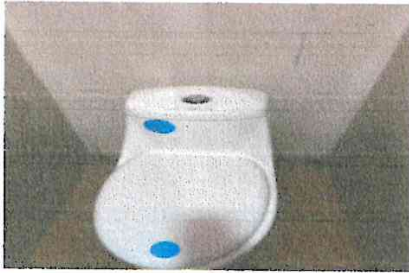
Foto 5: cambio de 5 baños con fluxometro
