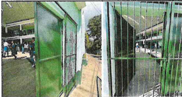
Foto 4: MANTENIMIENTO E INSTALACIÓN DE REJA EN PORTÓN DE ACCESO +. MANTENIMIENTO Y PINTURA
