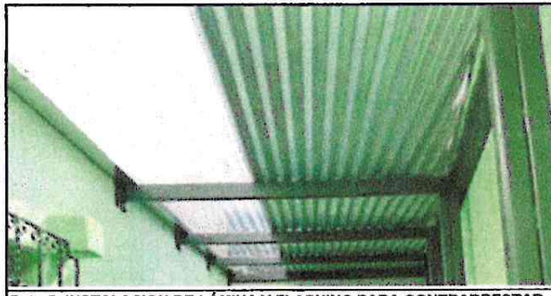
Foto 5: INSTALACION DE LÁMINA Y FLASHING PARA CONTRARRESTAR FILTRACIONES
