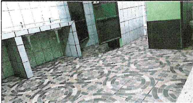
Foto 1: REVISIÓN Y MEJORAMIENTO DE FUGA DE AGUA EN SERVICIOS SANITARIOS DEL SEGUNDO NIVEL. RENANDO HUMEDAD EN DIRECCIÓN DE LA ESCUELA
