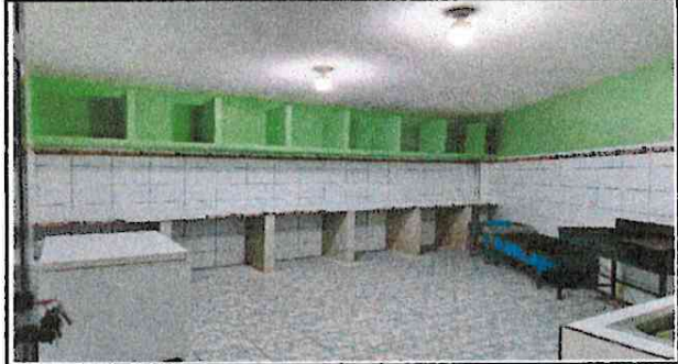
Foto 2: MEJORAMIENTO Y CONSTRUCCIÓN DE MÓDULO EN LA COCINA
