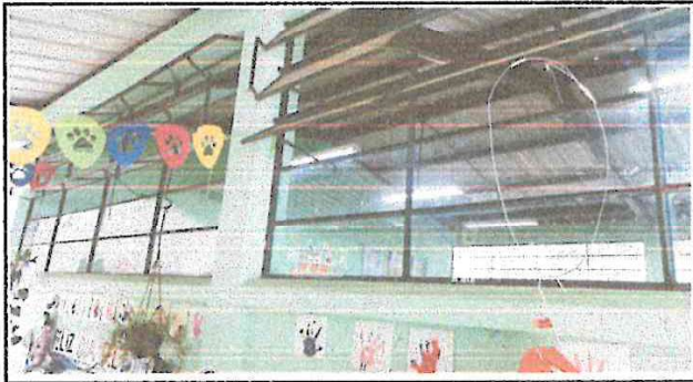
Foto 1: parte frontal de ventanas donde se colocaran balcones
