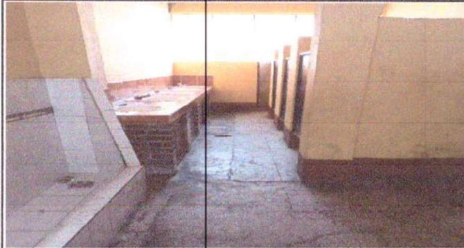
Foto 1: cambio de piso de cemento a piso de ceramica en sanitarios de hombres y mujeres del segundo nivel, y sanitarios los existentes ya estan deteriorados por el tiempo. Alumnos beneficiados 425.
