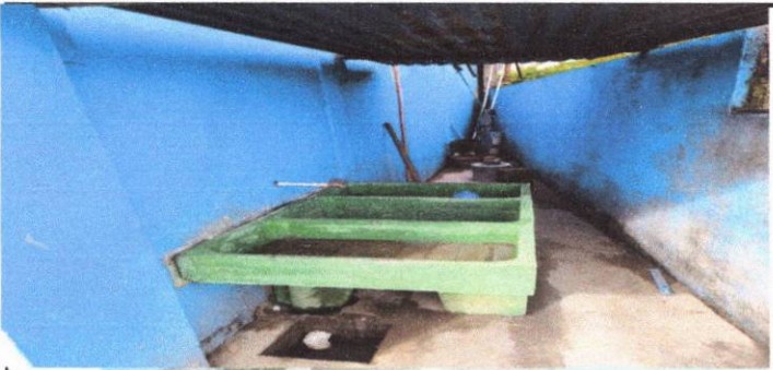
Foto 5: techado en el area de la pila
