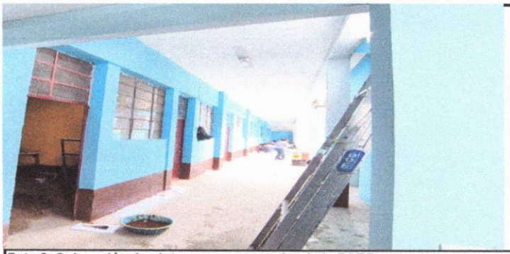
Foto 5: Colocación de pintura en area exterior de la EODP
