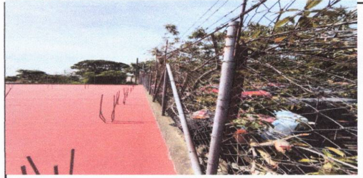
Foto 4: Colocación de malla en el area perimetral
