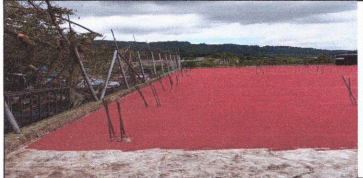
Foto 2: reforzamiento de malla perimetral.
