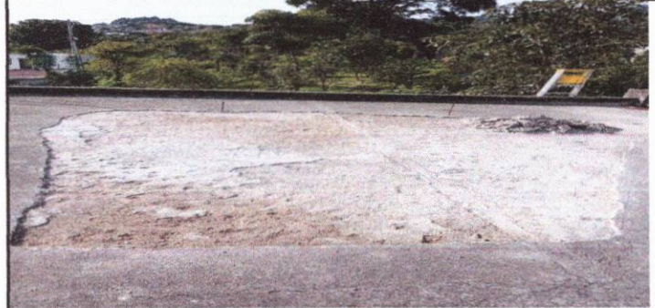
Foto 2: reforzamiento de malla perimetral.
