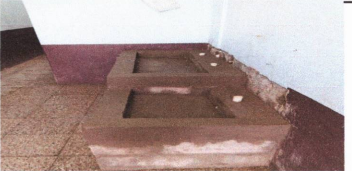
Foto 6: instalación de lavamanos en sanitarios
