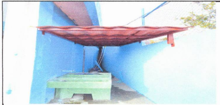
Foto 5: techado en el area de la pila
