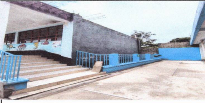
Foto 3: Colocación de Block con malla para asegurar el perímetro
