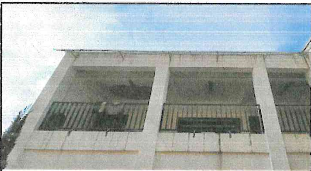
Foto 3: Area a techar
