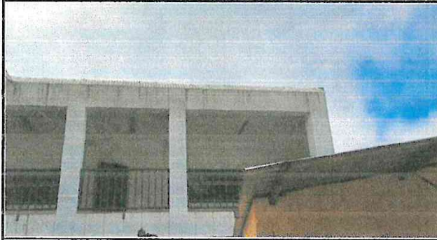
Foto 1: Area a techar
