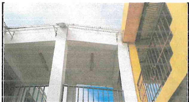
Foto 4: Area a techar
