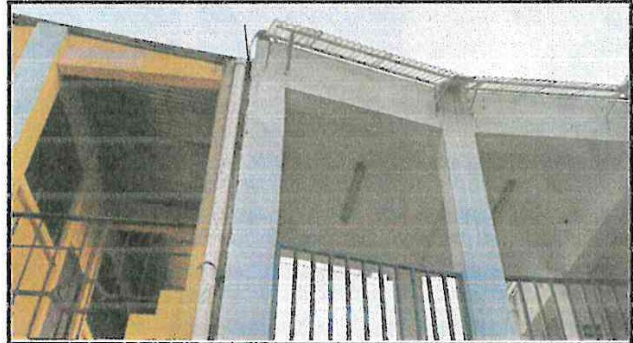
Foto 2: Area a techar
