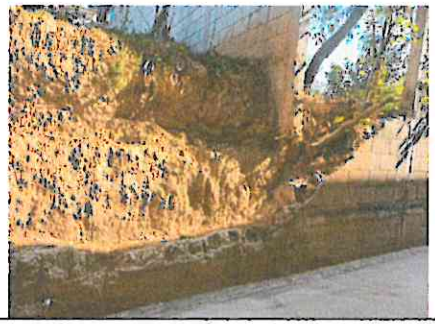
Foto 5: Es necesario para reponer el muro demoler las partes que aún permanecen del mismo.
