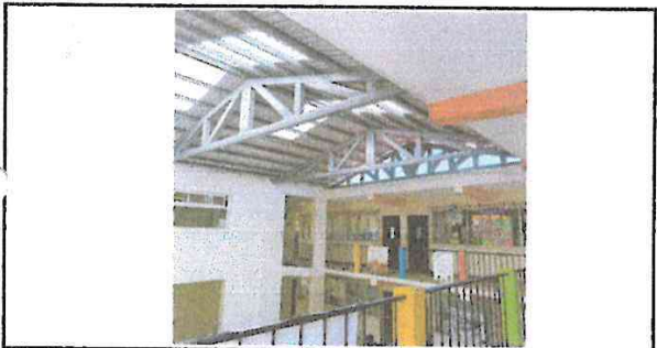
Foto 5: Desde el segundo nivel, en un quinto ángulo se observan el techo finalizado.
