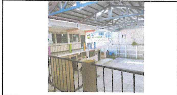
Foto 1: Fotografía del techado del patio finalizado desde un primer ángulo.
