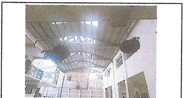
Foto 4: Vista desde un cuarto ángulo del área techada sobre el patio de la escuela.
