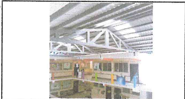
Foto 3: Fotografía de un tercer ángulo del área completamente techada.
