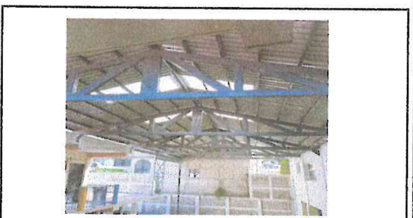
Foto 6: Vista desde un sexto ángulo del techo sobre el patio de la escuela.
