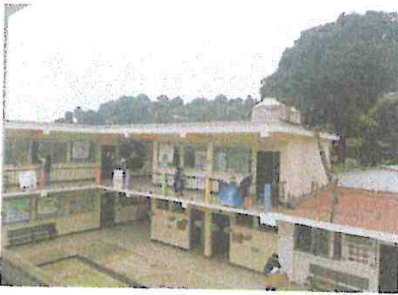
Foto 3: Fotografía de la vista desde un tercer ángulo del área a techar
