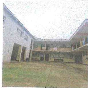
Foto 2: Vista desde un segundo ángulo del área a techar.
