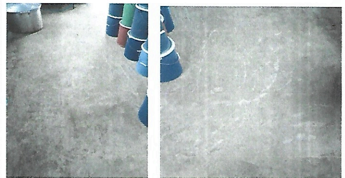
Foto 4: Sustitución piso de cocina.
