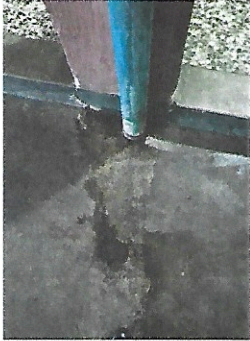
Foto 7: Cambio de bajadas de agua pluviales.
