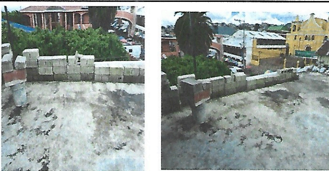
Foto 3: Mejoramiento de Pared Lineal tercer nivel pegado a cocina.
