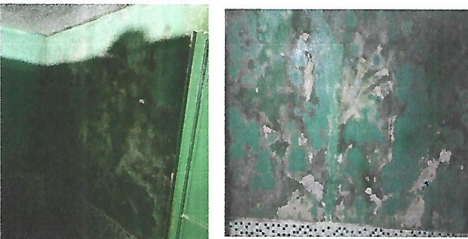
Foto 5: Mejoramiento de pared baños de Maestras.
