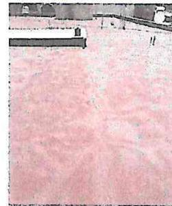
Foto 4: Los pañuelos de losa poseen fisuras y el agua de lluvia se está filtrando debajo del acabado de losa. Se hace necesario aplicar cernido en la losa.
