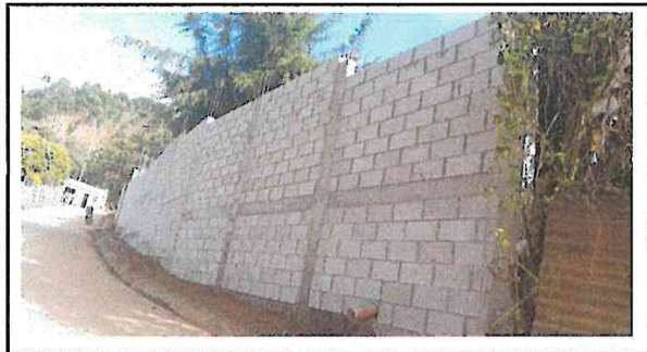
Foto 3: Suministro levantado de muro perimetral lado Este
