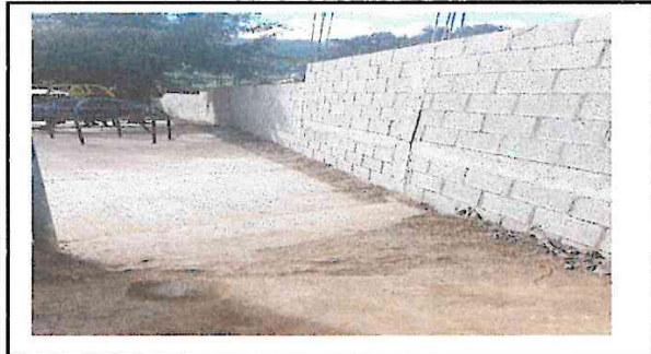
Foto 1: suministro levantamiento de muro perimetral area interna
