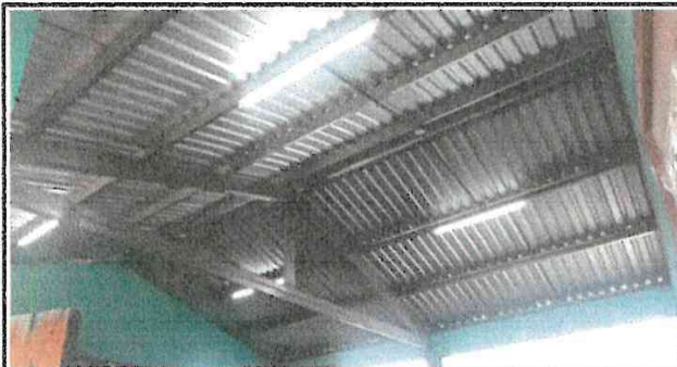
Foto 3: Mantenimiento y cambio de cableado electrico.
