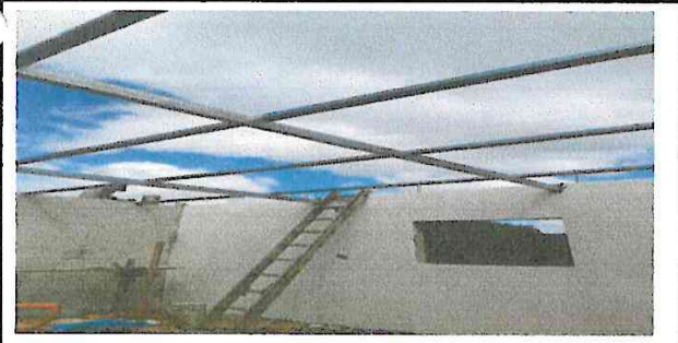
Foto 5: Instalación de techado.
