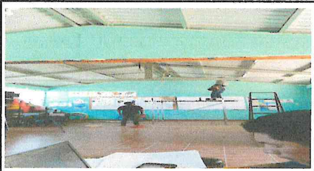
Foto 3: Mantenimiento y cambio de cableado eléctrico.
