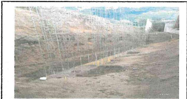
Foto 4: (Muro perimetral y de contención colapsando desde el interior (Área 2)
