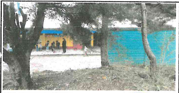
Foto 5: Muro perimetral vista desde afuera (Área de trabajo 1)
