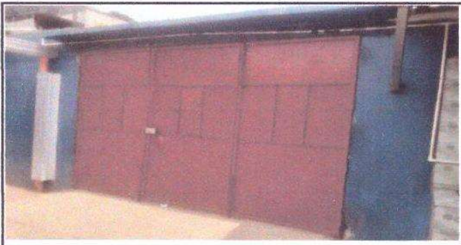
SUSTITUCION DE PORTON
