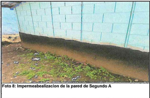
Foto 8: Impermeabilización de la pared de Segundo A
