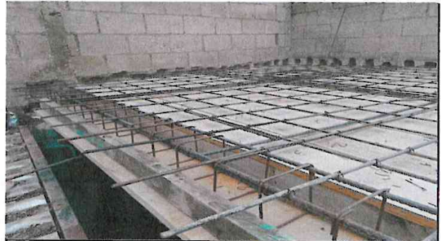
Foto 2: Cambio de techo de sanitarios para soporte de tinacos.
