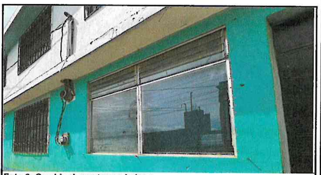
Foto 6: Cambio de ventana y balcon
