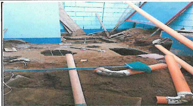
Foto 7: Mantenimiento de Drenaje y coneccion a linea principal
