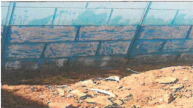
Foto 8: Impermeabilizacion de la pared de Segundo A
