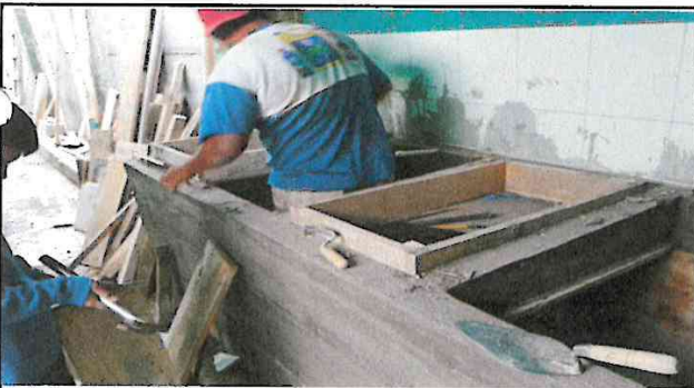
Foto 3: reparacion de pila y tuberias
