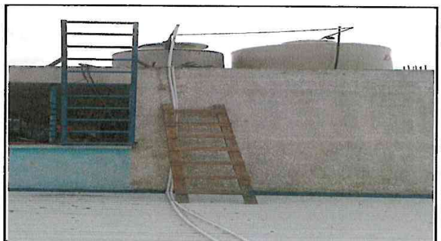
Foto 4: Cambio de tubería de tinacos
