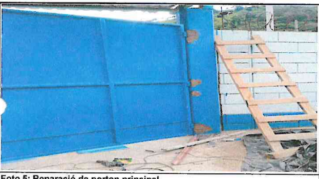
Foto 5: Reparació de porton principal
