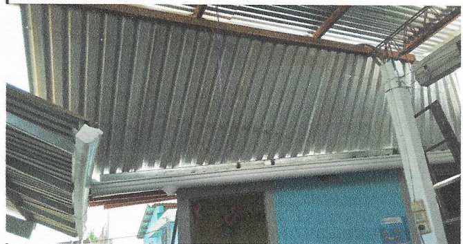
Foto 4: mejoramiento del techado
