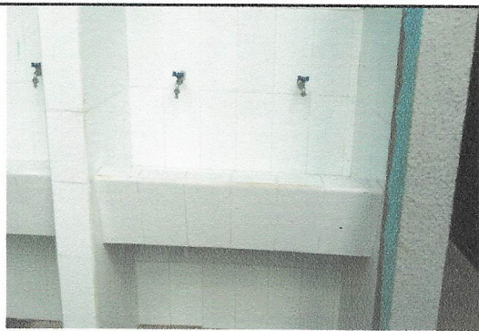
Foto 5: Mejoramiento de lavamanos
