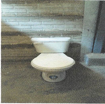
Foto 7: instalación de sanitario
