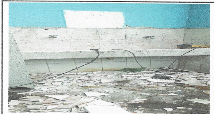
Foto 3: cambio de azulejo en lavamanos
