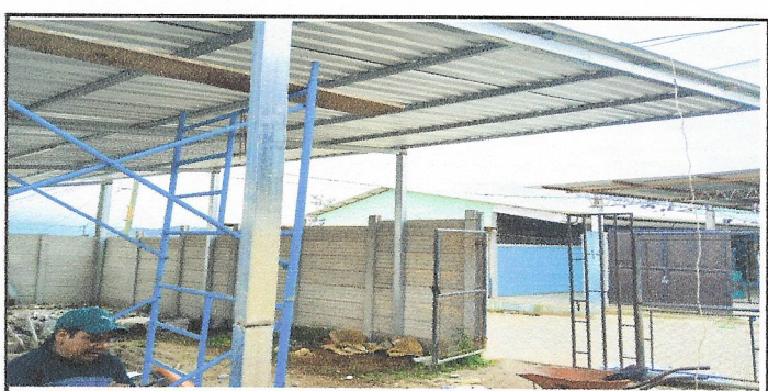
Foto 6: instalación de techado en patio
