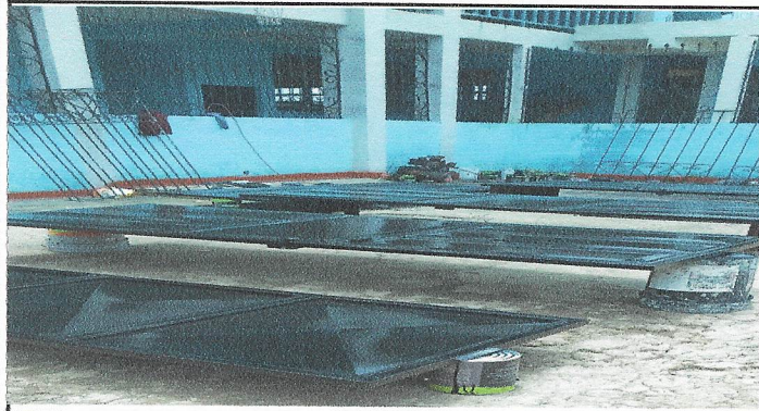
Foto1: Mantenimiento de puertas y balcones
