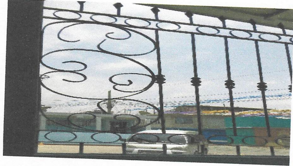
Foto 2: Mantenimiento de barandas y balcones
