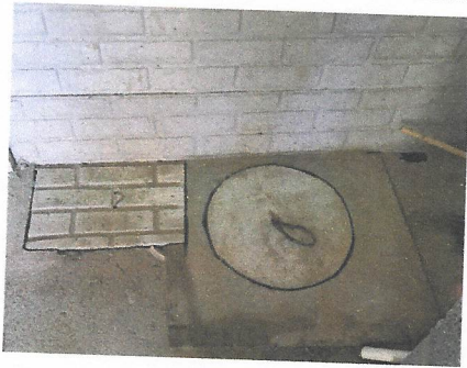
Foto 5: Mejoramiento del drenaje
