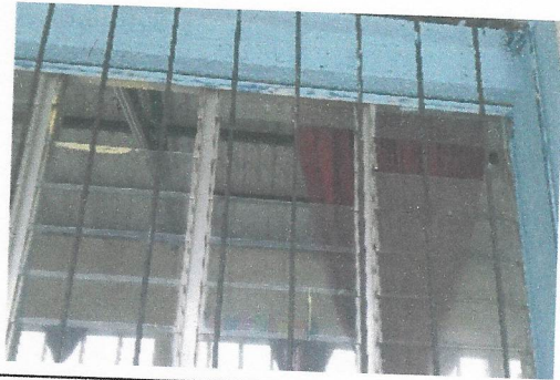
Foto 4: Cambio de vidrios de cocina y salón
