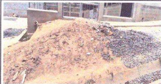
Foto 14: En esta entrada se pretende realizar gradas para mejorar ese espacio.
