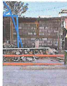
Foto 4: Mejoramiento de pared, en area perimetral e instalación de pilas
