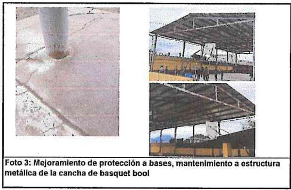
Foto 3: Mejoramiento de protección a bases, mantenimiento a estructura metálica de la cancha de basquet bool
