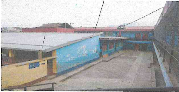
Foto 3: Pintar parte exterior segundo nivel. (sanitarios)
