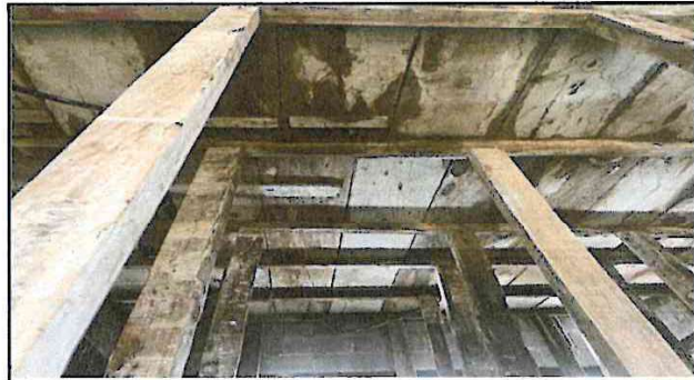
Foto 2: Modulo A: Finalización de chimenea en la loza de concreto.
