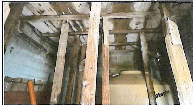
Foto 4: Modulo A: Finalización de loza en la bodega de agua.
