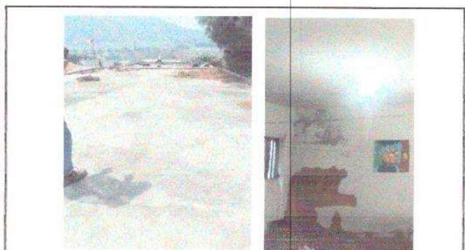
REPARACIÓN DE ÁREAS DAÑADAS DE LA LOSA
