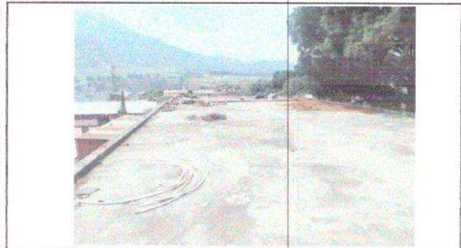
REPARACIÓN Y SELLADODE UNIONES ENTRE 3 MÓDULOS
