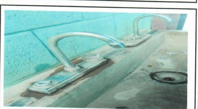
Foto 4: Cambio de chorros e instalación de mezcladora de agua en lavamanos de niños.
