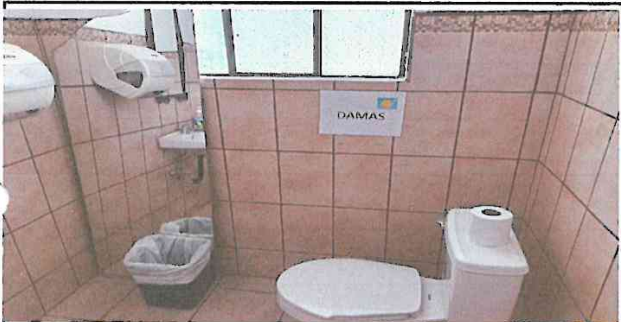
Foto 5: Finalizado en cambio de baño
