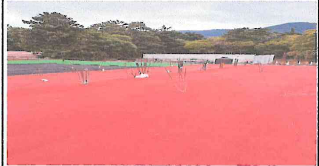
Foto 2: Terraza con impermeabilizante
