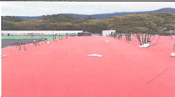
Foto 3: Terraza concluida en el trabajo de impermeabilizante
