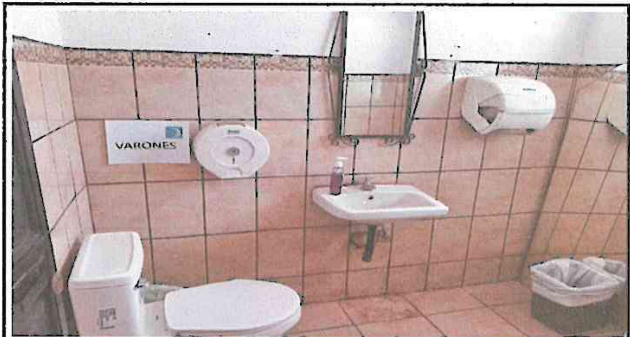
Foto 4: Baño concluido en azulejo
