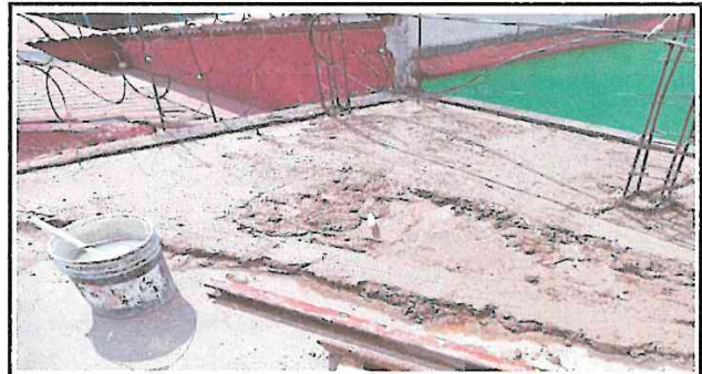
Foto 2: fundicion de bajadas de agua
