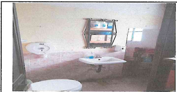
Foto 5: Cambio de azulejo y baños
