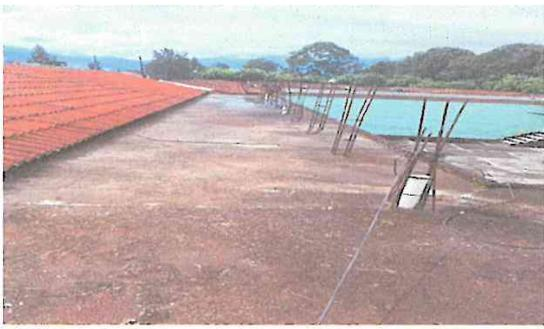
Foto 1: La terraza tiene filtraciones y necesita limpieza de arena volcánica
