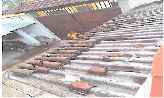
Foto 2: El Techo necesita colocar las tejas que ya no existen y tapan goteras
