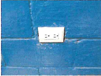
Foto1: se cambiaron tomacorrientes y cableado eléctrico
