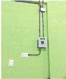
Foto 3: colocacion de cables electricos en ducto pvc electrico
