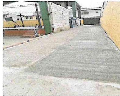
Foto 4: bacheo de concreto terminado
