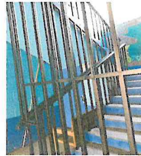
Foto 6: rejas y barandas en su estado actual
