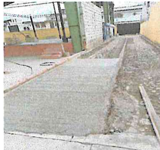
Foto 4: realizando trabajos de bacheo del concreto
