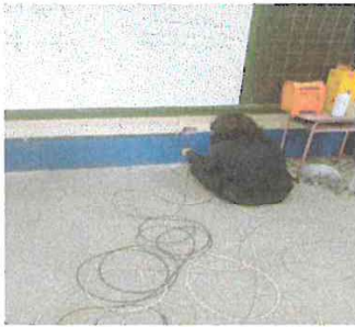
Foto1: cambiando el cableado electrico
