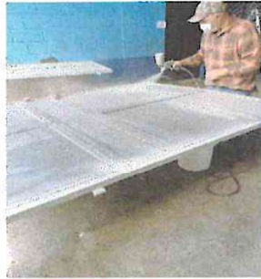
Foto 2: fondeando puertas de salida segundo nivel
