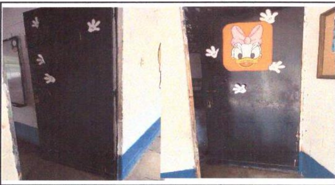
FOTO 11 MANTENIMIENTO DE PUERTA NO. 3 PUERTA NO. 4
