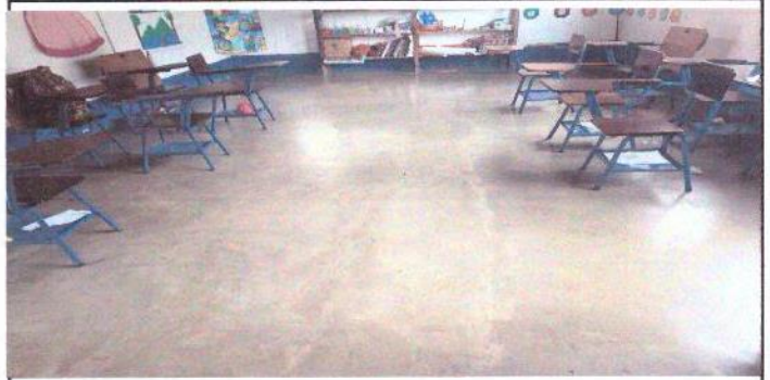
FOTO 2 SUMINISTRO E INSTALACION DE PISO CERAMICO AULA NO. 2
