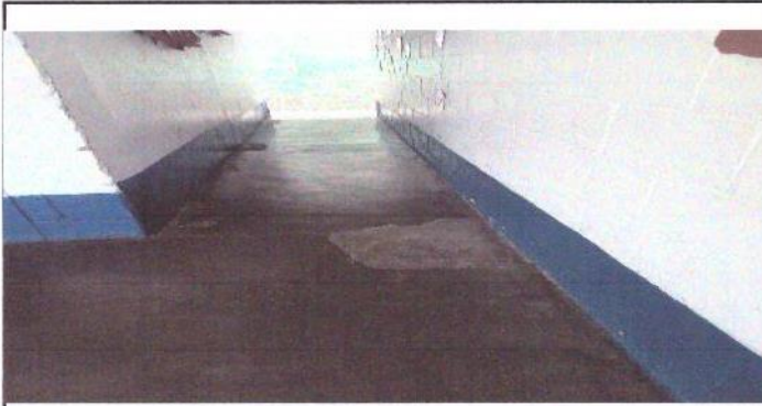
FOTO 7 SUMINISTRO E INSTALACION DE PISO CERAMICO CORREDOR DEL ESTABLECIMIENTO
