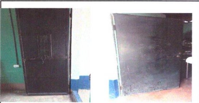
FOTO 11 MANTENIMIENTO DE PUERTA NO. 5 PUERTA NO. 6
