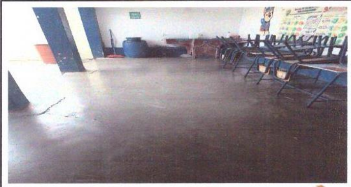
FOTO 8 SUMINISTRO E INSTALACION DE PISO CERAMICO CORREDOR DEL ESTABLECIMIENTO
