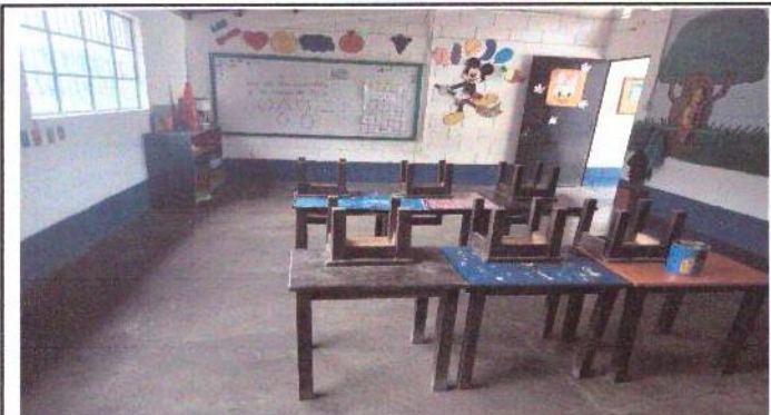
FOTO 3 SUMIISTRO E INSTALACION DE PISO CERAMICO AULA NO. 3
