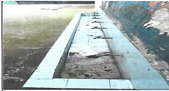
Foto 5: pileta en mal estado, azulejo, drenaje, chorros.
