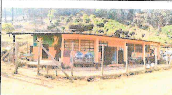
Foto 4: Parte frontal del área a mejorar con el muro perimetral.
