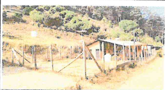
Foto 1: Vista panorámica desde el costado derecho de la escuela, donde se observa la importancia del muro perimetral.
