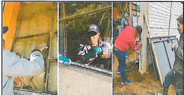
Foto 6: Se observa el momento durante se instalan los vidrios en las ventanas. También se observa en momento en el que se está a punto de instalar el portoncito de la escuela.
