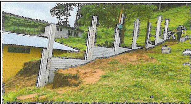
Foto 3: se observa el avance del muro perimetral en la parte izquierda de la escuela desde una posición frontal (de norte a sur)
