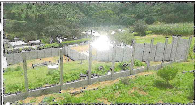
Foto 3: se observa el avance del muro perimetral en la parte izquierda de la escuela desde una posición frontal (de norte a sur) Aunque la fotografía se capturó del sur al norte (atrás de la escuela, costado derecho)
