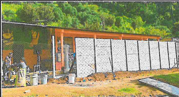
Foto 1: Se observa el muro perimetral en la primera parte del frente de la escuela, desde la derecha hacia la izquierda en una posición frontal (de norte a sur)
