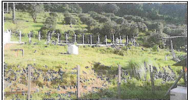
Foto 4: Se observa el avance del muro en la parte de atrás de la escuela (lado sur)
