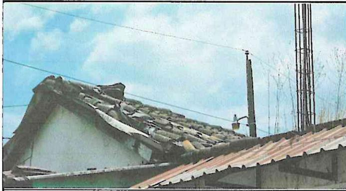
Foto1: las láminas tienen filtraciones
