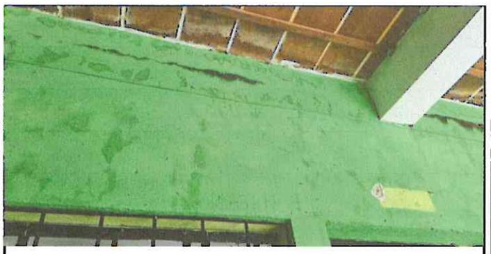
Foto 6: es todo el techo con filtraciones y se ha deteriorado
