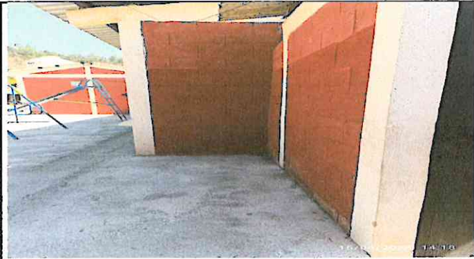
Foto 3: Instalación de una pila con drenaje y techo.
