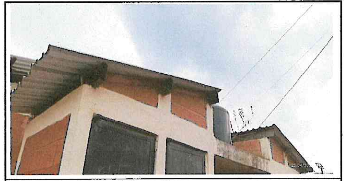
Foto 6: cambio de techo de los sanitarios.
