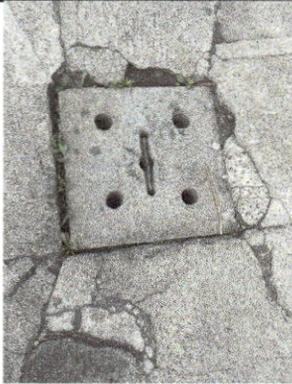
Foto 7: Módulo B, reposadera en mal estado
