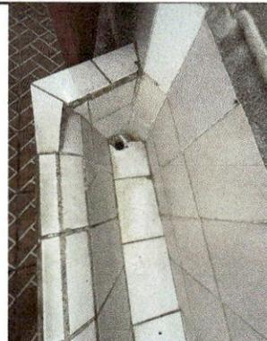
Foto 10: Módulo D, desfogue en mal estado
