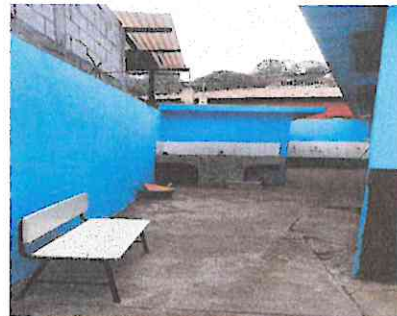
Foto 6: Construcción para 4 baños y cambio de pila
