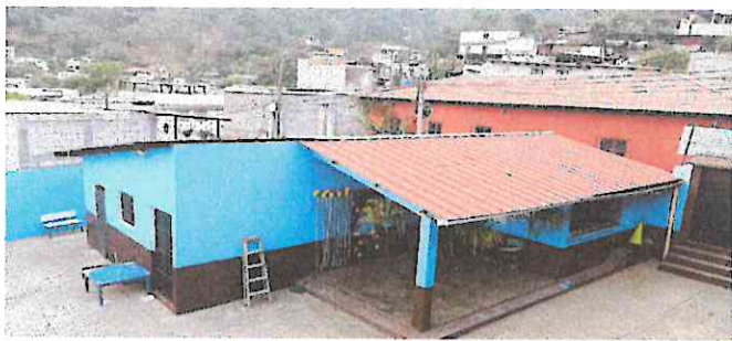
Foto 5: Cambio de Lámina por terraza
