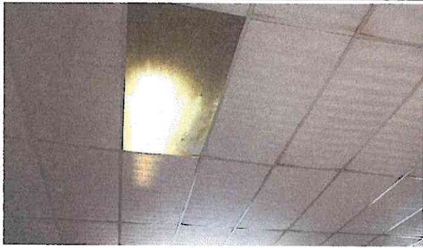
Foto 3: Cambio de iluminación en toda la escuela
