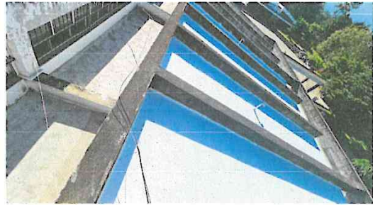
Foto 2: Finalización de impermeabilización
