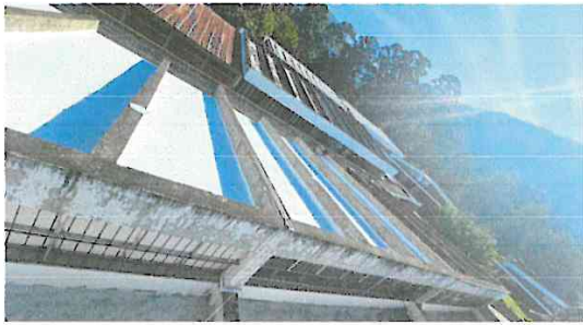
Foto 1: Finalización de impermeabilización
