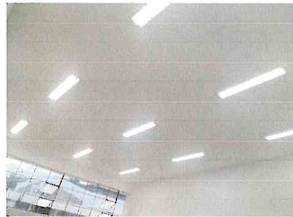
Foto 4: Colocación de Gasneones
