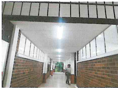
Foto 3: Colocación de Gasneones
