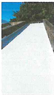
Foto 5: Finalización de impermeabilización
