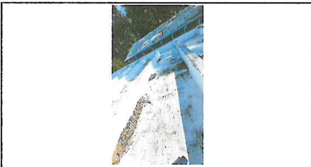
Foto 3: Limpieza de area para impermeabilizar
