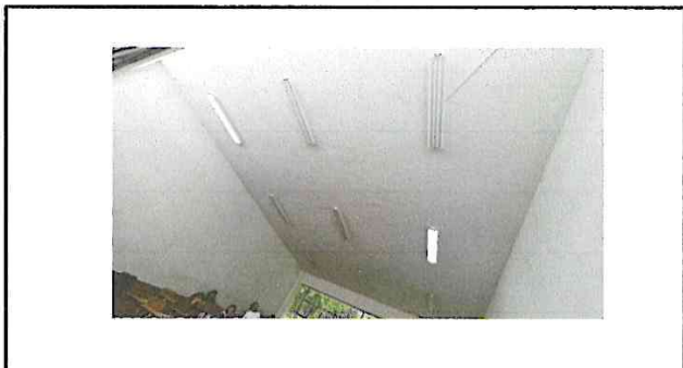
Foto 4: Cambio de gasneones
