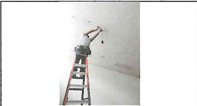
Foto1: Colocación de Gasneones
