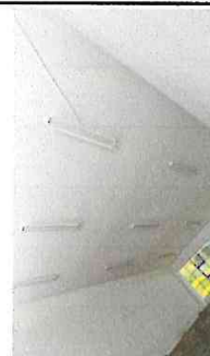
Foto 6: Instalación de gasneones
