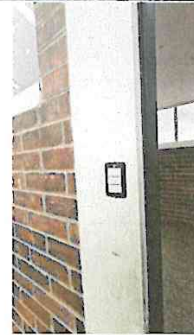
Foto 4: Instalación de tomacorrientes
