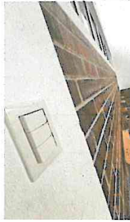
Foto1: Instalación de tomacorrientes
