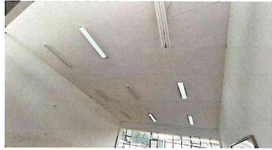
Foto 2: Instalación de gasneones
