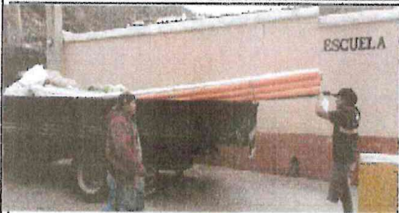
Foto1: DIA 16 RECEPCION DE MATERIAL ES Y CONTINUACION DE TRABAJOS
