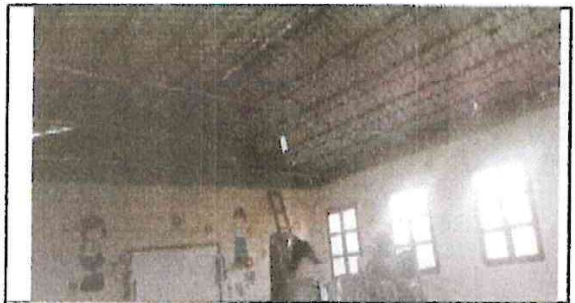
Foto 3: DIA 15 CONTINUACION DE DESMONTAJE DE CIELO FALSO
