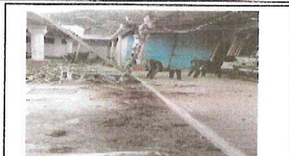
Foto 2: DIA 15 DESMONTAJE DE CANALES
