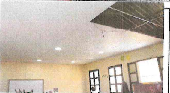
INSTALACION DE CIELO FALSO
