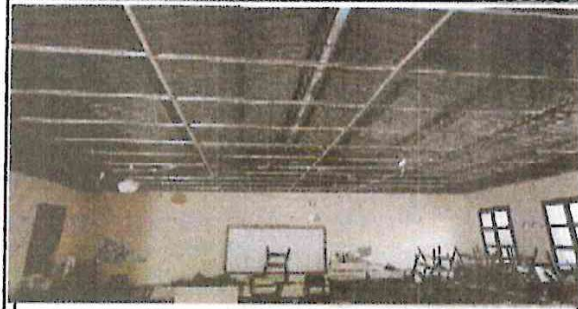
INSTALACION DE ESTRUCTURA METALICA PARA LA COLOCACION DEL CIELO FALSO
