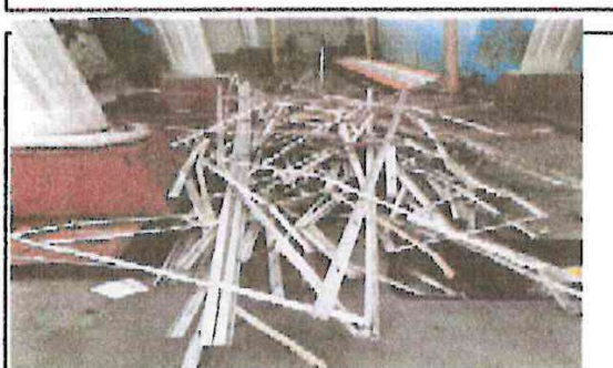
Foto 4: DIA 18 CONTINUACION DE TRABAJOS
