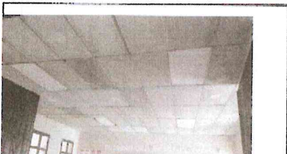
Foto 3: DIA 16 CONTINUACION DE DESMONTAJE DE CIELO FALSO
