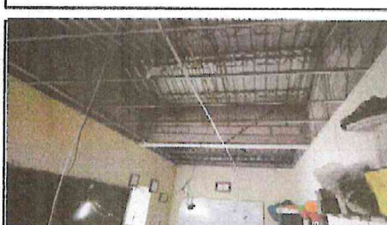
INSTALACION DE ESTRUCTURA METALICA PARA LA COLOCACION DEL CIELO FALSO
