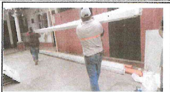
Foto 2: DIA 16 RECEPCION DE MATERIALES Y CONTINUACION DE TRABAJOS
