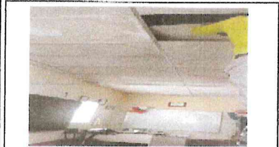
Foto 3: DIA 15 CONTINUACION DE DESMONTAJE DE CIELO FALSO
