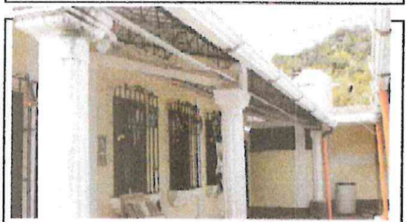
INSTALACION DE ESTRUCTURA METALICA PARA LA COLOCACION DEL CIELO FALSO
