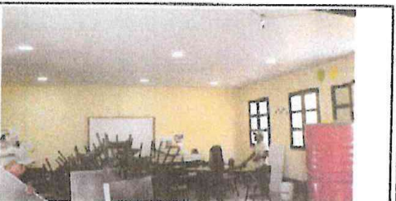
INSTALACION DE CIELO FALSO
