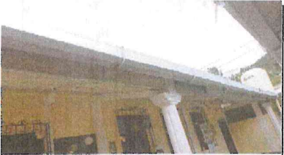
Foto 4: CAMBIO DE CIELO FALSO Y PINTURA DE EXTERIORES DE AULAS
