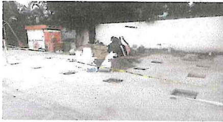
Foto7: Suministro y nivelación de piso de patio
