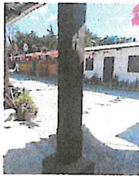
Foto 11: Suministro, restauración y mantenimiento de pilares de madera
