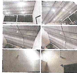
Foto 4: Limpieza, aplicación de pintura de Joist de cubierta en salones
