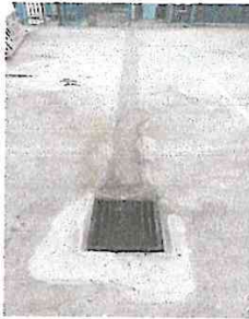
Foto 1: Suministro y sustitución de tubería de PVC para bajadas pluviales en patio
