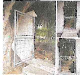
Foto 2: Reparación y aplicación de pintura en puerta tipo malla
