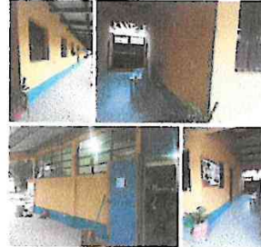
Foto 8: Suministro y aplicación de pintura
