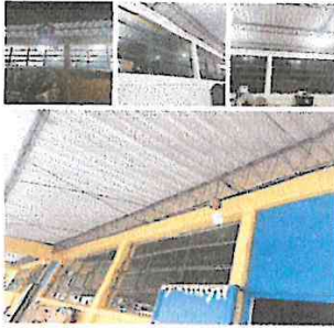
Foto 15: Suministro e instalación de vidrios en ventanales
