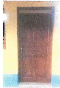
Foto 10: Restauración de puerta de madera solida de salón
