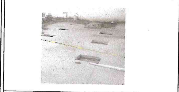
Foto 7: Suministro y nivelación de piso de patio
