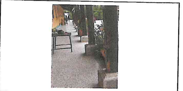
Foto 11: Suministro, restauración y mantenimiento de pilares de madera
