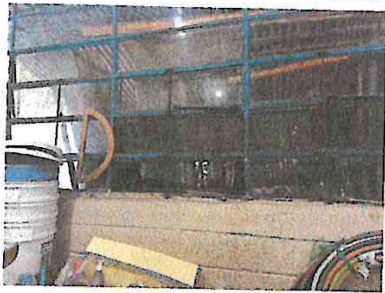
Foto 15: Suministro e instalación de vidrios en ventanales
