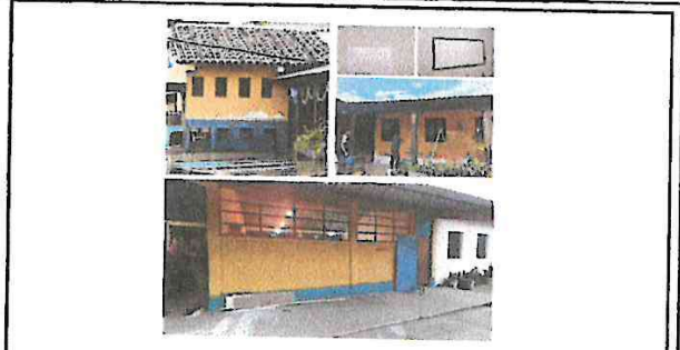
Foto 8: Suministro y aplicación de pintura
