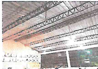
Foto 30: Unidades eléctricas de luz
