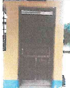
Foto 16: restauración puerta de madera
