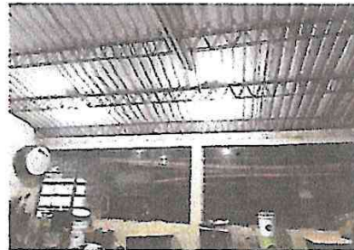
Foto 28: unidades eléctricas de luz
